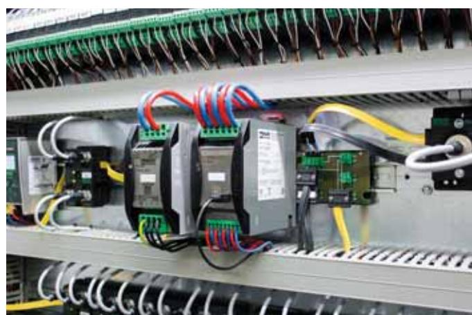
K UPS modulu sú pripojené externé olovené akumulátory s kapacitou do 40 Ah, ktoré umožňujú dlhé doby premostenia. Podľa potreby sa dá použiť variant s 20 A alebo 40 A. Montáž sa vykonáva bez potreby náradia. 20 A variant si vyžaduje len to, aby bola v skriňovom rozvádzaci navyše voľná stavebná šírka iba 65 milimetrov.
